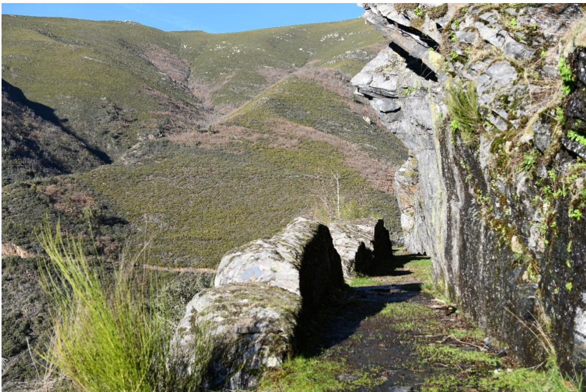
Corte en la roca del canal C-1 en Llamas de Cabrera (León)
